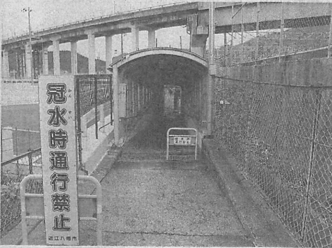
女性がなくなった地下歩道。右手にJRの線路が通り、道路奥側は県道の地下歩道に接続している(近江八幡市安土町)
